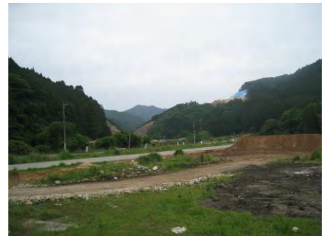
建設中の伊良原ダムの様子
