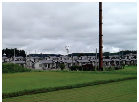
災害公営住宅（調査が終了した写真の左側にも建設予定）
