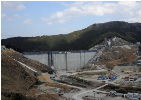
急ピッチで建設中の伊良原ダム
